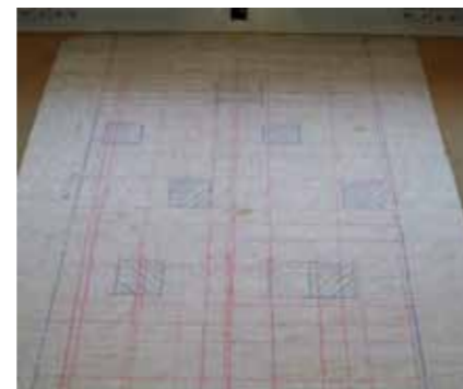
Rode lijnen: locatie wapening, blauwe lijnen: zijkant vloerbalk, blauwe vierkanten: locatie om VZA vrij te stralen.
