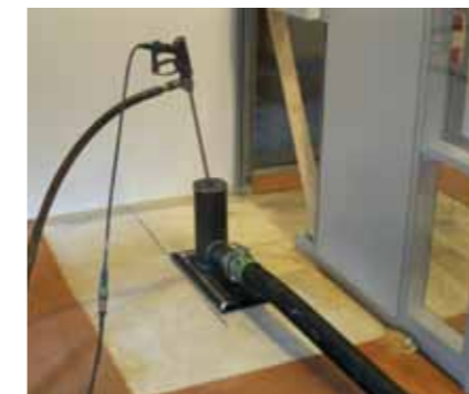
Opstelling voor het middels hoge druk water spuiten, vrijmaken van de voorspanstrengen.
